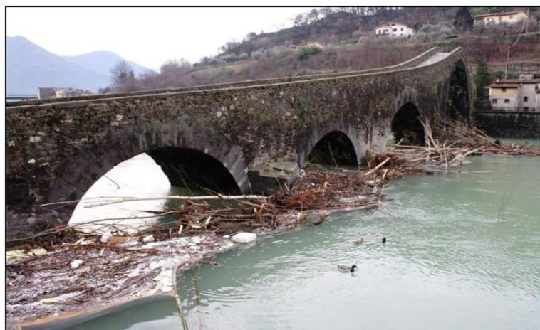
Figura 5 – Esempio di occlusione della luce di un ponte a causa dei detriti arborei (Borgo a Mozzano – LU)
