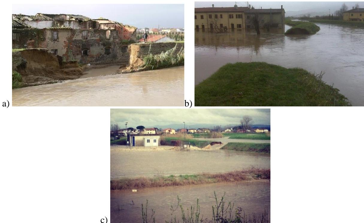
Figura 3: Esempi di eventi di piena in cui si sono verificati delle inondazioni a seguito del meccanismo di collasso arginale e non a causa del sormonto arginale. a) Ombrone Pistoiese (Dicembre 2009); b) Calice (Dicembre 2009); c) Torrente Brana (Pistoia, 2013).
