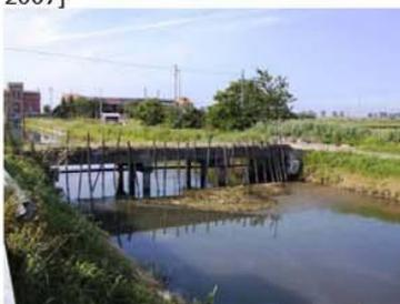
Figura 3 - Sezione trasversale di raccolta della vegetazione fluitante. Esempio di "ferme" per raccogliere la vegetazione sfalcciata. [da Consorzio di Bonifica Dese Sile, 2001]
