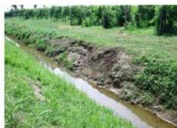
Figura 1 - Erosione e cedimento del piede di sponda. [da Consorzio di Bonifica Dese Sile, 2007]
