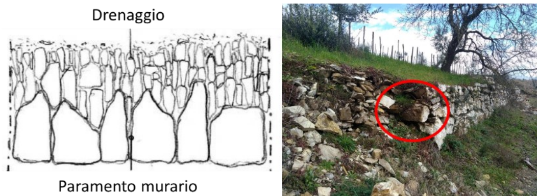
Figura 41: (Sinistra) Schema evidenziante come le pietre del paramento murario e del drenaggio dovrebbero essere disposte di punta tratto da "Manuale per la costruzione dei muri a secco - Linee guida per la manutenzione dei terrazzamenti delle Cinque Terre. (Destra) foto di porzione di muro franato, da cui si evidenzia come all'interno del paramento originale fossero presenti blocchi rivolti di punta, quindi con il lato più lungo rivolto verso l'interno a scopo di ancoraggio.
