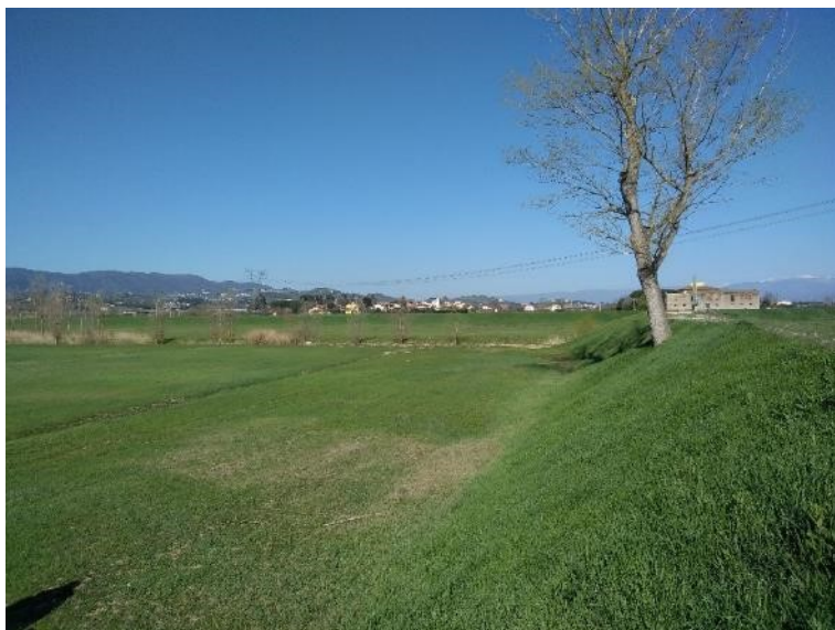
Figura 44: Esempio di ciglione con manto erboso ben sviluppato e correttamente gestito.
