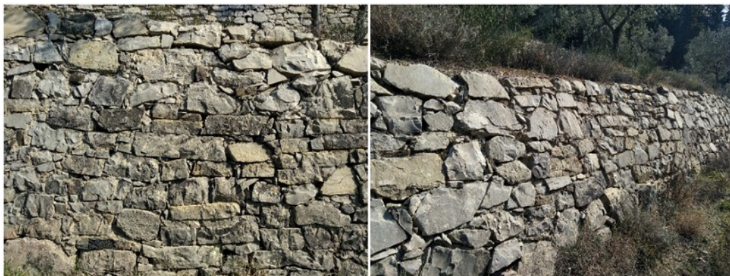
Figura 43: Si vede bene in questa immagine il notevole lavoro di tassellatura effettuato. Tutti gli spazi sono occupati da pietre riducendo al minimo la possibilità di movimento delle pietre maggiori e incrementando la solidità della struttura.
