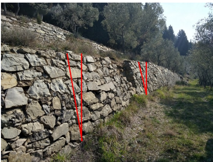
Figura 42: In questa immagine si evidenzia la scarpa, ovvero l'inclinazione del filo esterno del paramento murario, valutata rispetto ad un piano verticale.
