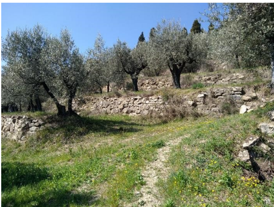
Figura 13: Ripiani terrazzati mediante muretti a secco nelle colline di Sesto Fiorentino
