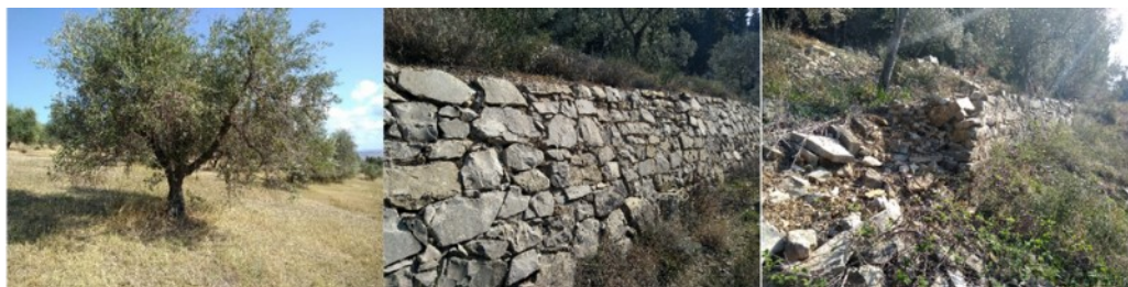
Figura 35: studio volto a valutare l'efficacia delle sistemazioni a rittochino e dei terrazzamenti sulla riduzione della perdita di suolo dovuta all'erosione idrica e quindi confrontare l'erosione originata nei campi con terrazze non degradate rispetto a campi con terrazze ormai degradate (ovvero completamente o parzialmente crollate)
