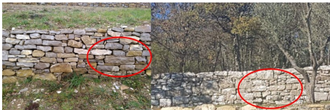
Figura 40: Nelle due immagini si può osservare come le pietre di file successive siano tra loro sfalsate in modo tale da sfalsare i giunti verticali e migliorare l'ammorsamento della struttura
