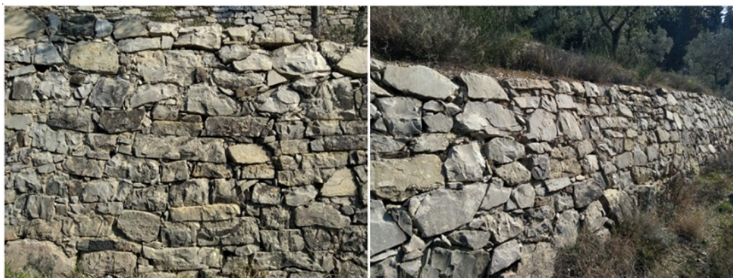
Figura 46: Esempi di muretti a secco correttamente tassellati.
